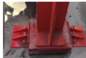
Sicherung gegen seitliches verrutschen mittels Winkelbleche
